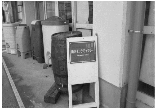
すみだ環境ふれあい館の雨水タンクギャラリー 様々なタイプのもがある。植木の水やりや洗濯などに利用でき水道代の節約にもなる。
